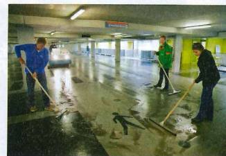
写真5 ■ 液体の補修材で床面のひび割れを補修する様子。液体の補修材は日本国内で2017年の夏に販売を始める予定。そのほかの材料の国内での発売時期は未定だ
