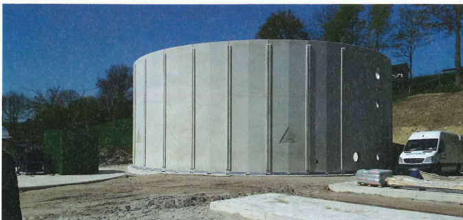
写真2 ■ 混和材を試験的に採用したタンク。直径18m、高さ7m、厚さ30cmで、壁体の一部に使用した。2016年に構造物が完成し、現在、施工後の状況をモニタリングしている
