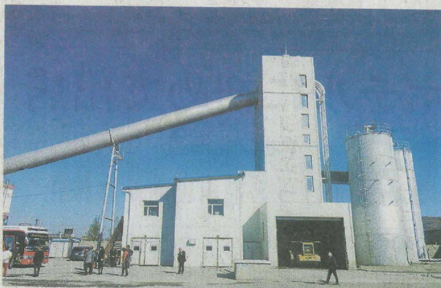
ウランバートル郊外に立地するAIZAWA MONGOLの生コンプラント
