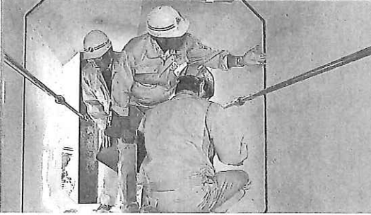
ボックス内部に入り、水漏れがないか見る参加者
